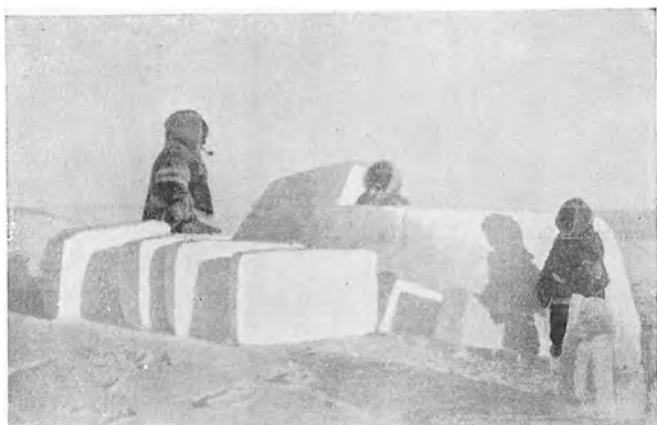
Iglulik-Eskimoer i færd med at opføre et snehus. Bygmesteren står selv inde i huset, mens hans hjælpere skærer blokke udenfor og skyder dem ind til ham gennem en åbning fornedet i muren. (Th. Mathiassen fot.).
