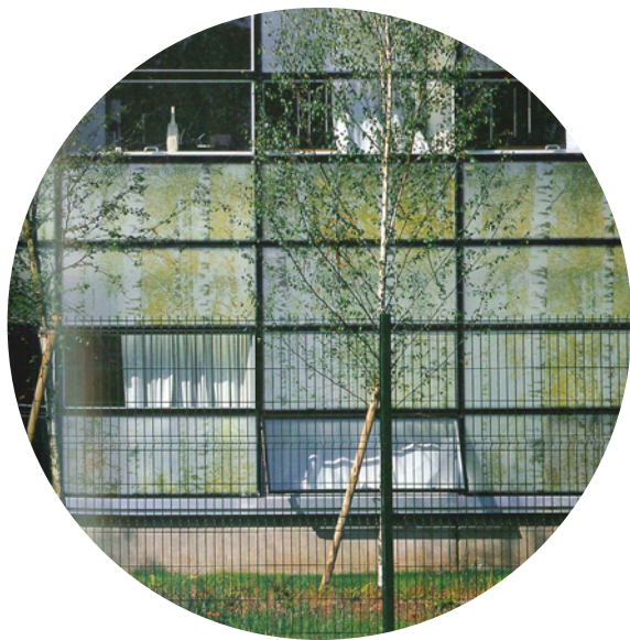
REFERENCE PRINTET MØNSTER PÅ GLAS FACADEN DIFFERENTIERTERER LYSET / SKÆRMER FOR INDBLIK
