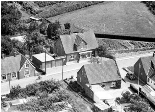
El-forretningen i Ørum 1955.
