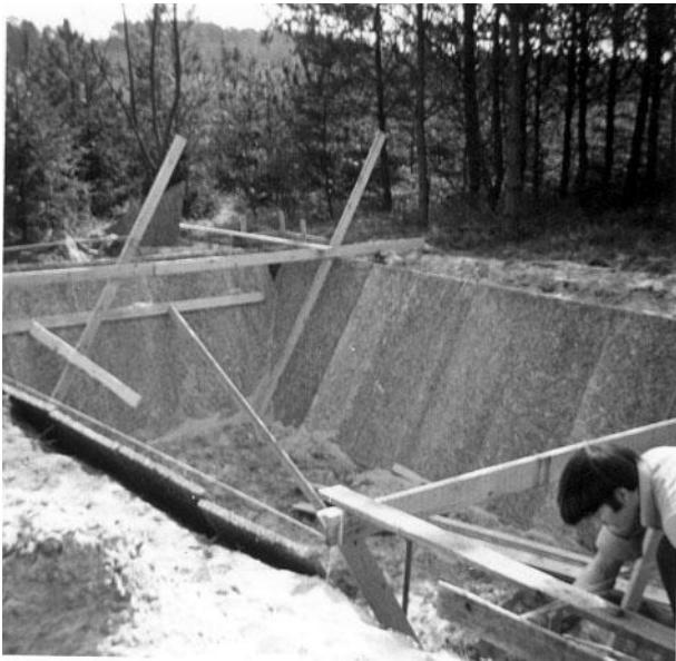
Udgravning til svømmebassin.
