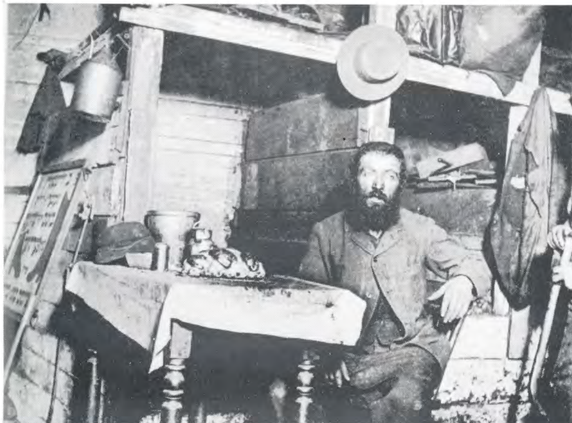
I en kulkælder.
